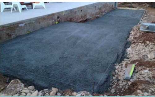
1 - Béton de propreté
