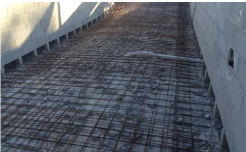
3 - Alphabloc associé aux blocs de coffrage enduits + ferrailage
