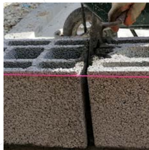
Rebouchage mortier 3 mm à 50 mm
