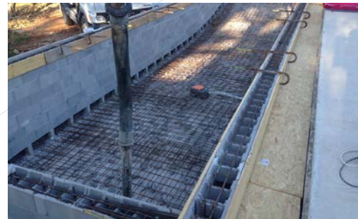
4 - Coulage du radier et murs en une seule opération
