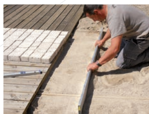
Égaliser le lit de pose à l'aide d'une règle
