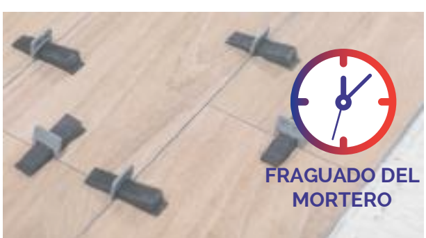
5. Esperar secado / Allow for setting / Attendre que cela sèche
