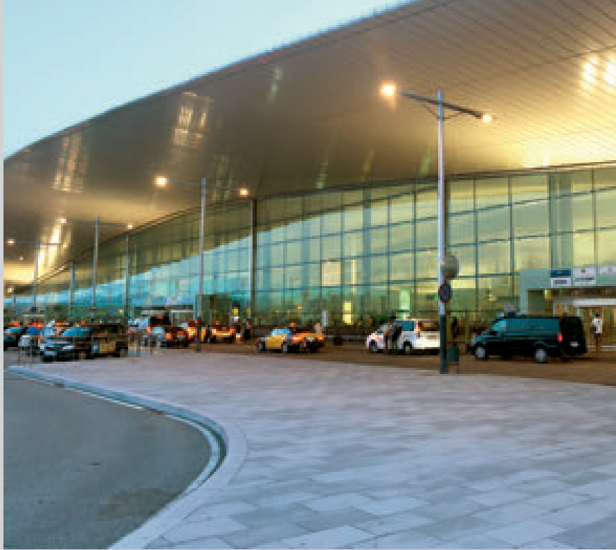
Proyecto Aeropuerto terminal 1 de Barcelona, España | Terminal 1 Barcelona airport project, Spain
