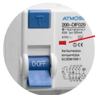
El diferencial se dispara cuando detecta una fuga de corriente residual y aparece el indicador en rojo como se muestra en la imagen.
