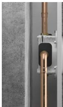
5. Instalación en celdas prefabricadas.
