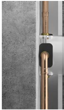
2. Instalación en la pared.
