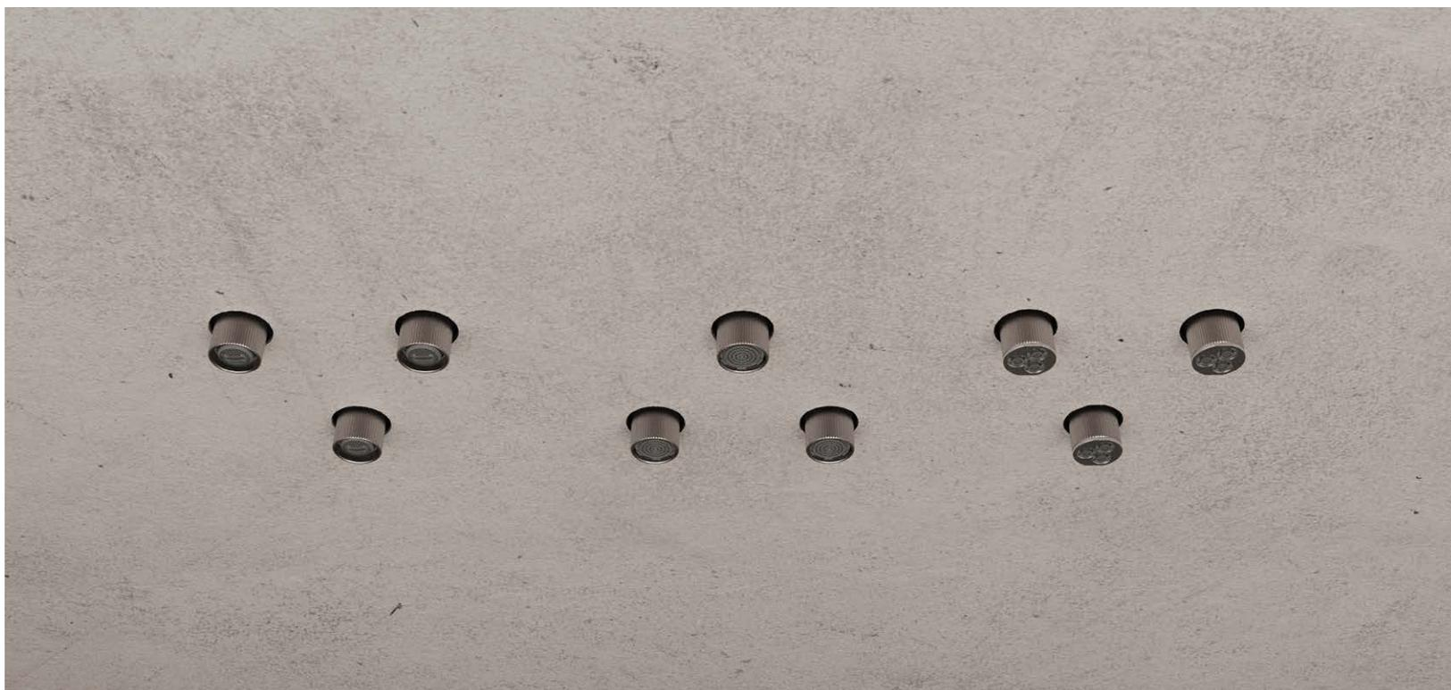
Sistema doccia Waterdot a 3 funzioni RAIN + ENERGY + MIST. La funzione 1 è composta da tre getti RAIN collegati tra loro, la funzione 2 è composta da tre getti ENERGY e la funzione 3 è composta da tre getti MIST. Il collegamento a un sistema SWITCH permette di controllare facilmente le tre tipologie di getto a soffitto e disporre di un ulteriore comando per la doccetta a parete.
