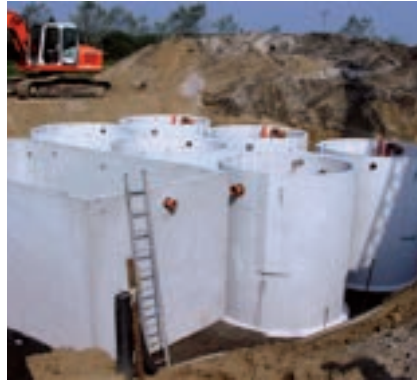
Depuradora hotel. Klaro 400 HE
