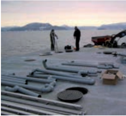
Depuradora astillero. Klaro 1.000 HE
