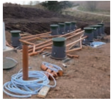
Depuradora fábrica de lácteos. oneAdvanced 350 HE
