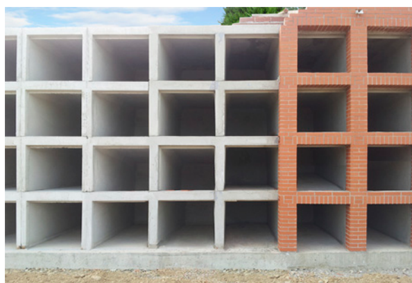
Detalle frontal de los nichos pendientes de revestir
